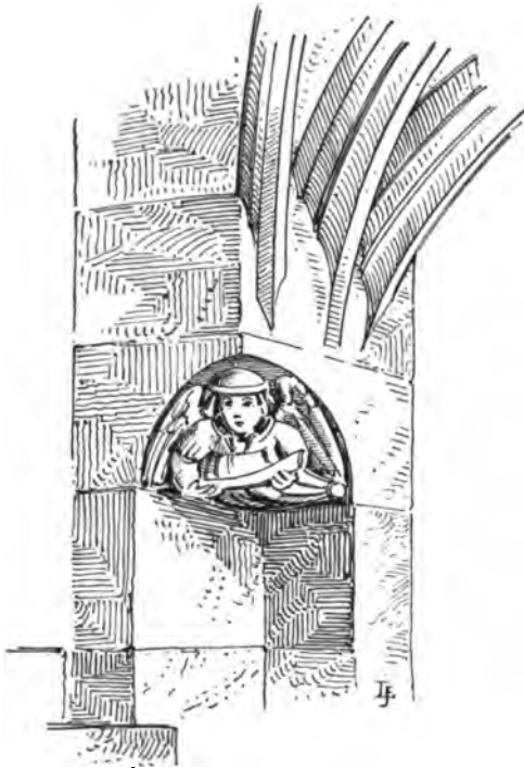
Fig. 89. Lorch. Pfarrkirche. Gewölbansatz in der äusseren Vorhalle.
